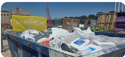
Sistema de segregación y gestión diferenciada de residuos implantado en obra para favorecer la valorización y la trazabilidad.
